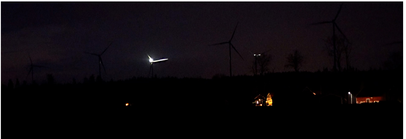
Bild 1, verk med kraftigt felaktig hinderbelysning
