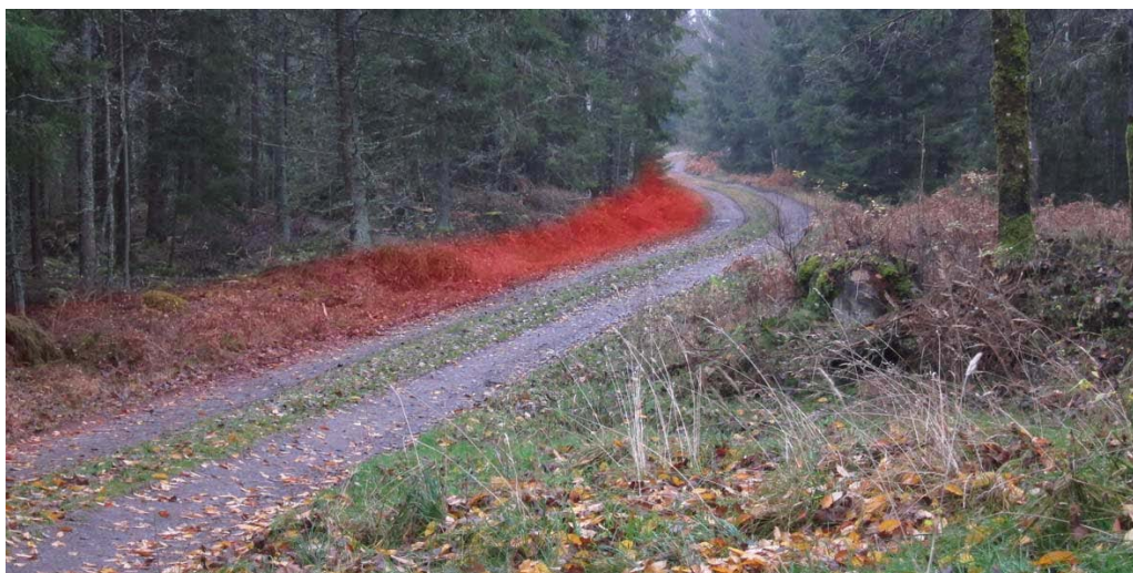
Anpassad vägförstärkning anges med röd markering, resterna från torpet återfinns till höger utanför bilden. Bilden är tagen i anslutning till objekt 1 mot syd.
