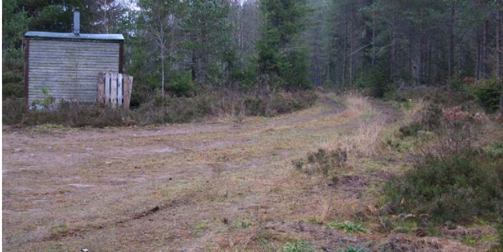
Befintlig väg från den skarpa svängen. Bilden är tagen i riktning mot öst. Till vänster i bild syns delar av den öppna plan som utgör svängen. Sannolikt har den öppna ytan tillkommit för rådande timmertransporter.
