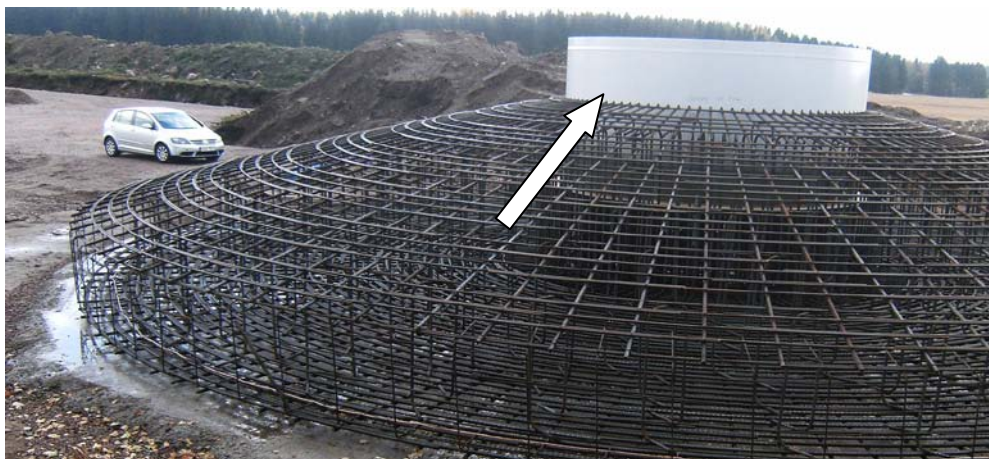
Slutförd armering med ingjutningsgods, se pil
