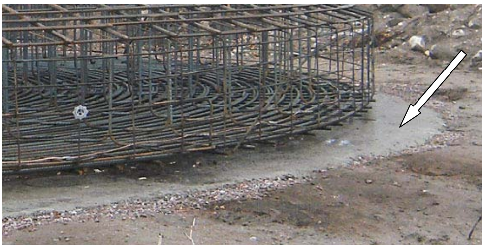
Grovbetong, se pil
