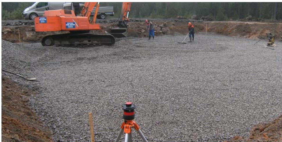
Markberedning med utplanad och packad markbädd
