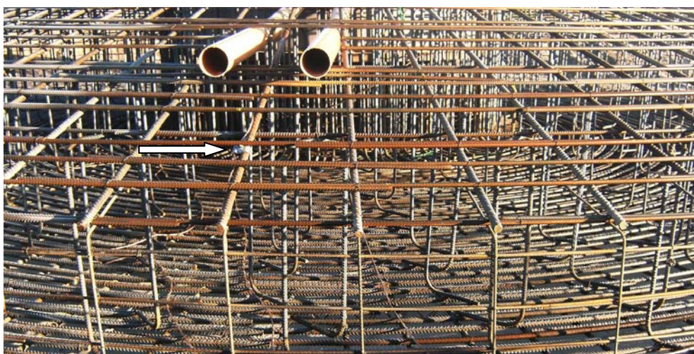
Potentialutjämning (pil) och kabelgenomföring
