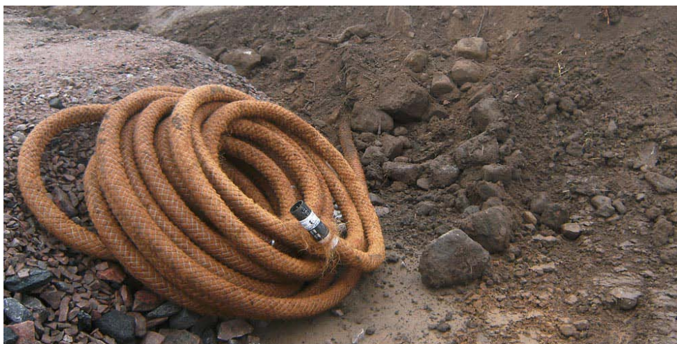
Kokoslang för dränering av fundamentet
