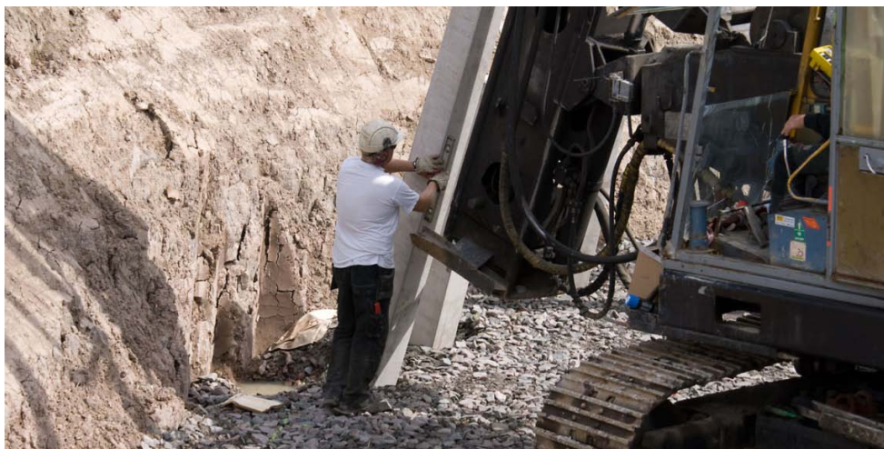
Justering av yttre pålråd som slås med vinkel för att öka lastupptagningen
