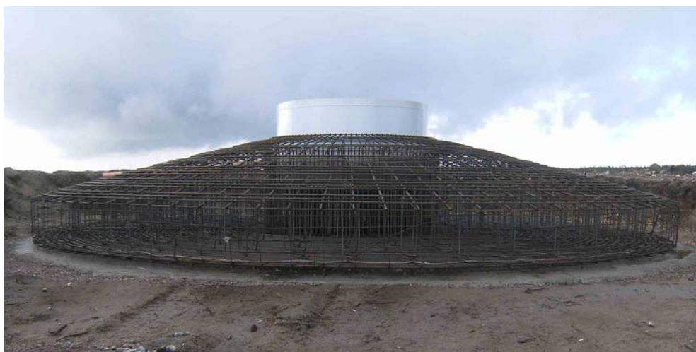
Slutförd armering med ingjutningsgods
