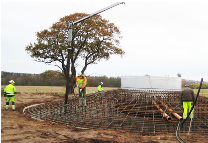
Figur 3 Gjutning av ett fundament i Skara – oktober 2009
